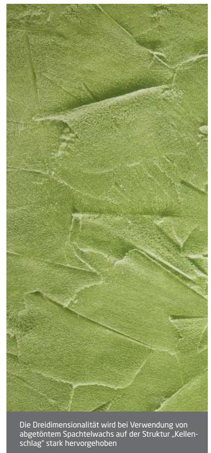
Die Dreidimensionalität wird bei Verwendung von abgetöntem Spachtelwachs auf der Struktur „Kellenschlag“ stark hervorgehoben
