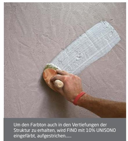
Um den Farbton auch in den Vertiefungen der Struktur zu erhalten, wird FINO mit 10% UNISONO eingefärbt, aufgestrichen.....
